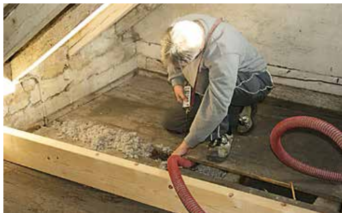
Dämmung einer Holzbalkendecke durch Einblasen von Zelluloseflocken
