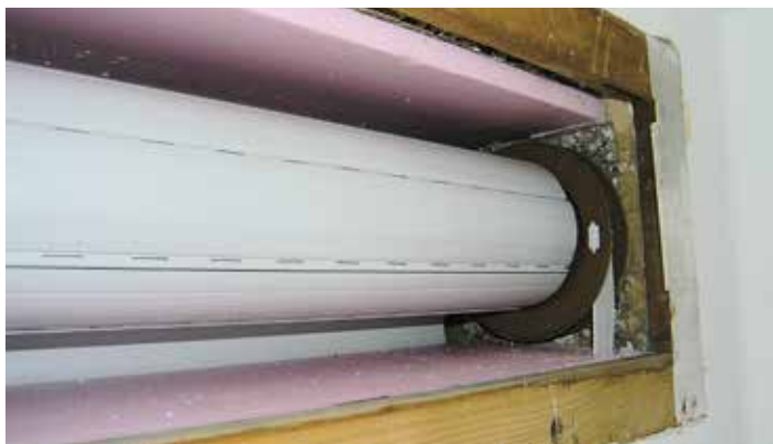
Nachträglich gedämmter, alter Rollladenkasten mit neuem Rollladen
