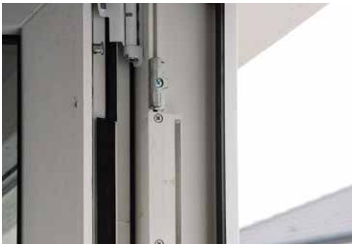
Fensterfalzlüfter: Die Klappe im Rahmen reagiert auf Winddruck.
