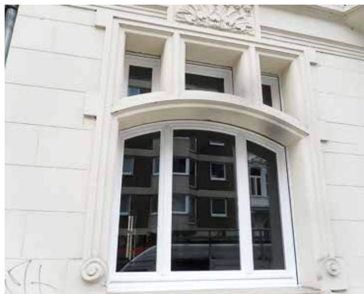
Neues Fenster in altem Haus
