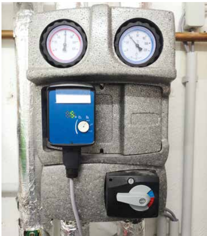
Moderne Umwälzpumpe (aktuelle Leistung: 5 Watt)
