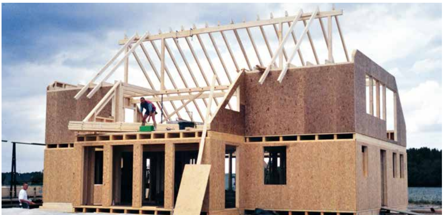
Außenwanddämmung mit Holzweichfaserplatten
