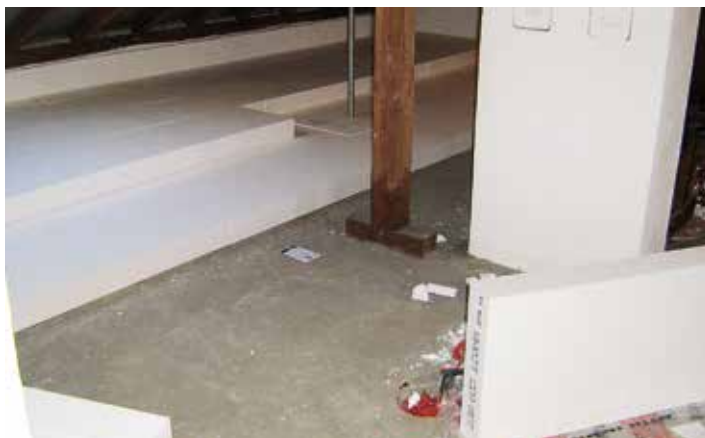
Zweilagige Dämmung eines Speicherbodens
