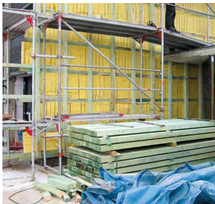
Vorhangfassade vor dem Anbringen der 2. Dämmstofflage und der abschließenden Verkleidung („Vorhang“)
