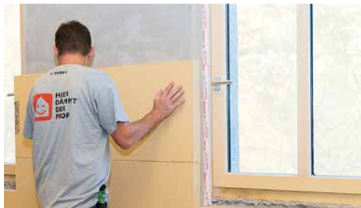
Anbringen einer Innendämmung, hier mit Holzfaserplatten.
