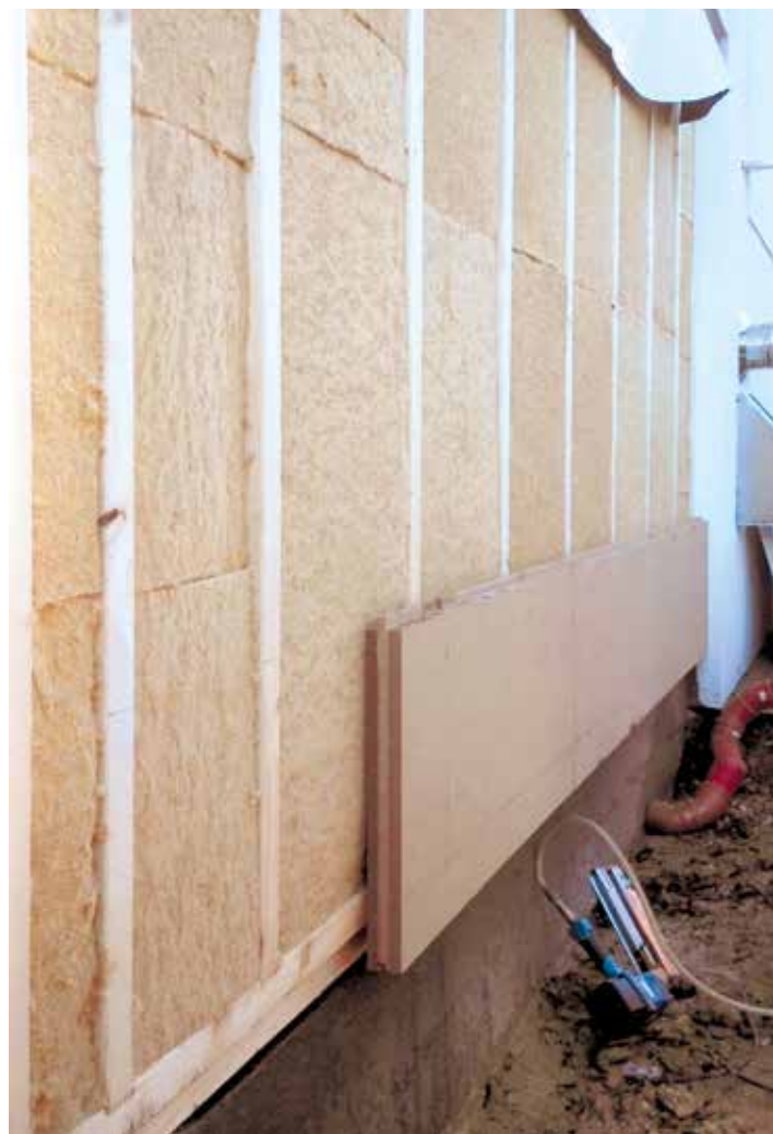
Wärmedämmverbundsystem Holzweichfaserplatten vor dem Verputzen
