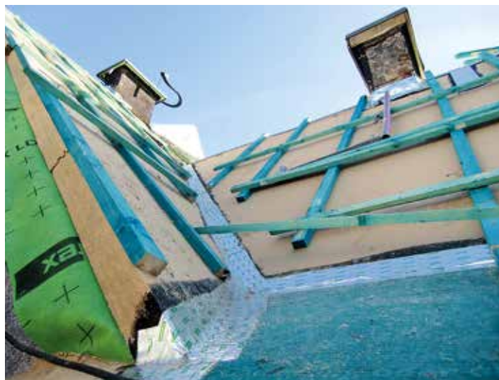
Dämmung auf den Sparren, hier mit Holzfaserplatten (Sanierung von außen)
