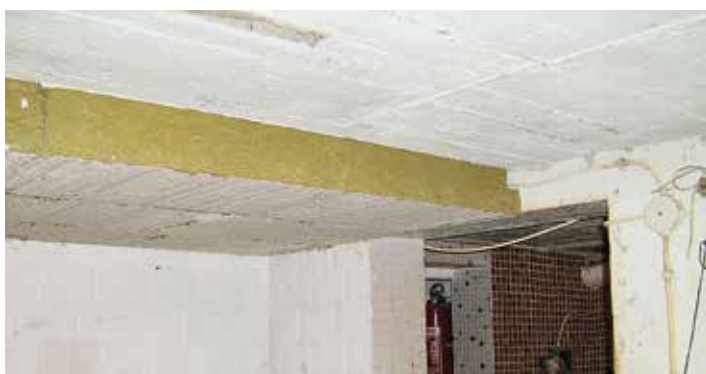
Dämmung der Kellerdecke von unten (hier mit Mineralfaserplatten)
